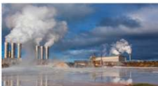
▲ Planta geotermal: aprovecha el calor de fuentes termales para vaporizar el agua y mover grandes turbinas, generadoras de electricidad.
