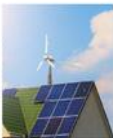
▲ Paneles solares instalados en las cubiertas de las casas para captar la luz del sol y convertirla en energía eléctrica.
