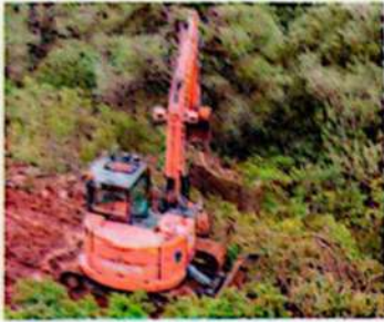
▲ Excavadora destruyendo la vegetación.
