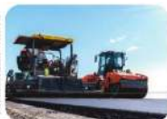
Pavimentación de una carretera.
