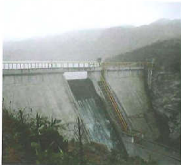
▲ Durante el auge petrolero, se construyó la Central Hidroeléctrica de Pisayambo en Tungurahua.
