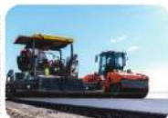
Pavimentación de una carretera.
