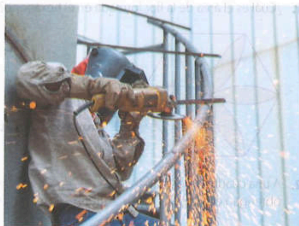
Trabajador que utiliza la molienda eléctrica en la estructura de acero.
