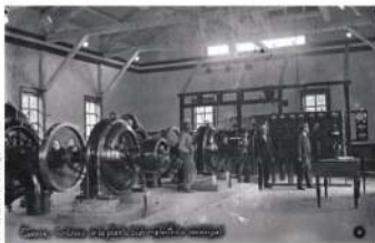
▲ Turbinas de la planta hidroeléctrica municipal de Cuenca, año 1918.
