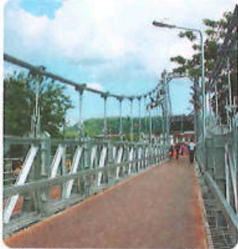
Puente de estructura metálica.
