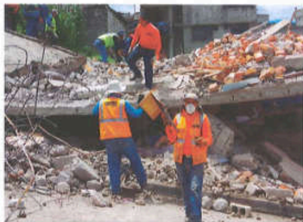
▲ El terremoto de abril de 2016 ocasionó la destrucción de muchas viviendas construidas con materiales precarios y sin los permisos debidos.
