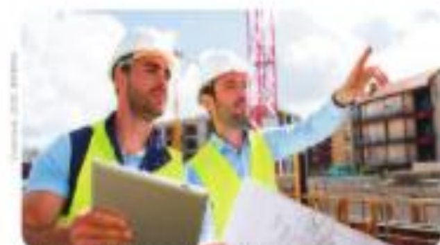
Arquitectos supervisando una obra.
