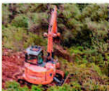
▲ Excavadora destruyendo la vegetación.
